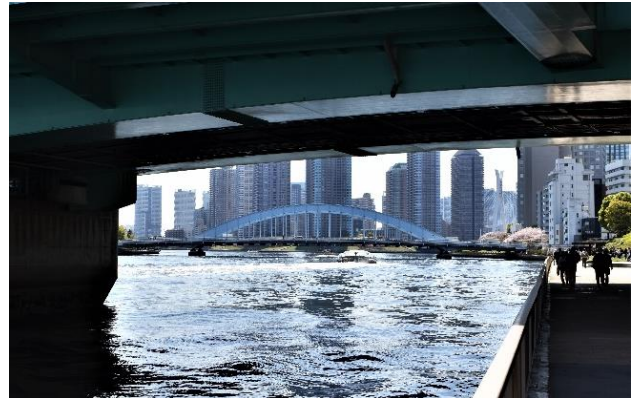
隅田川大橋高架橋下から永代橋を望む 12:25
