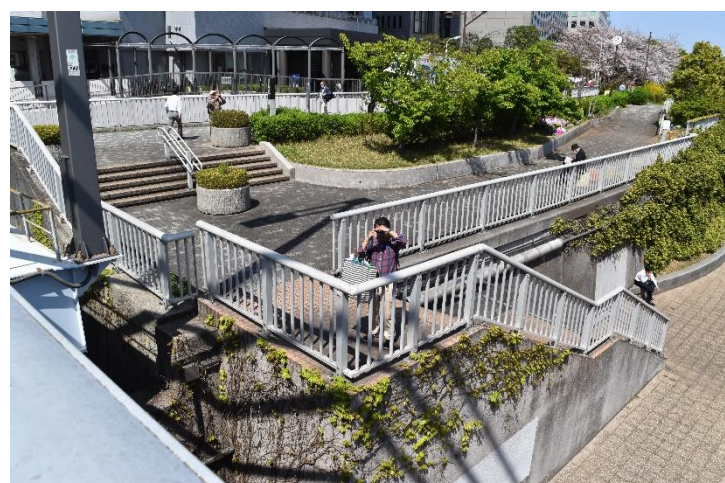
隅田川テラスから中央大橋への登り口 12:45
