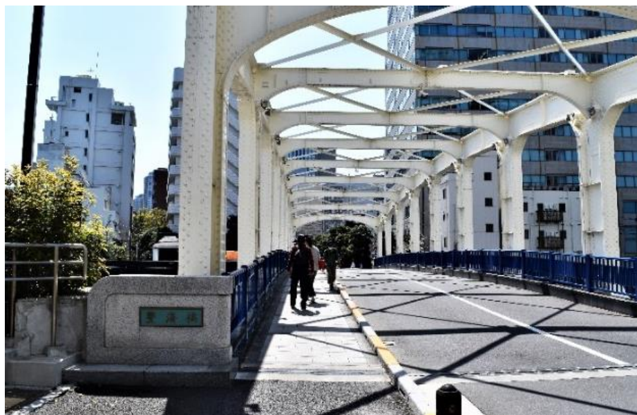
豊海橋を渡る 12:30 (1927年に震災復興橋として隅田川に流入する日本橋川に架設された)
