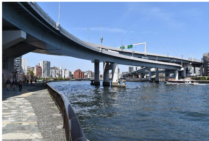
両国 JCT 高架を下流側から望む 11:57
