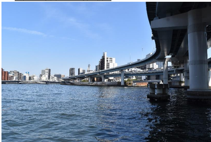
両国 JCT 高架下から上流側を望む 11:56
