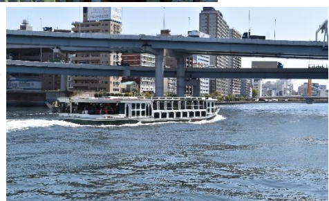
首都高速の 6 号線と 7 号 線の両国 JCT を望む その下を遊覧 船が通る
