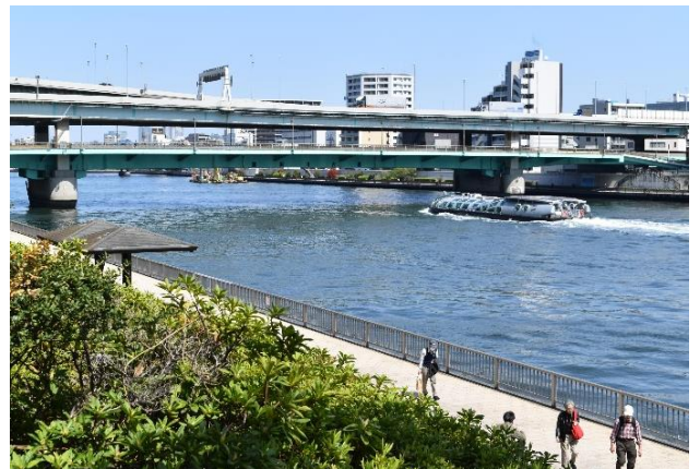
上の道から上流の首都高速9号線と隅田川大橋を望む 12:29
